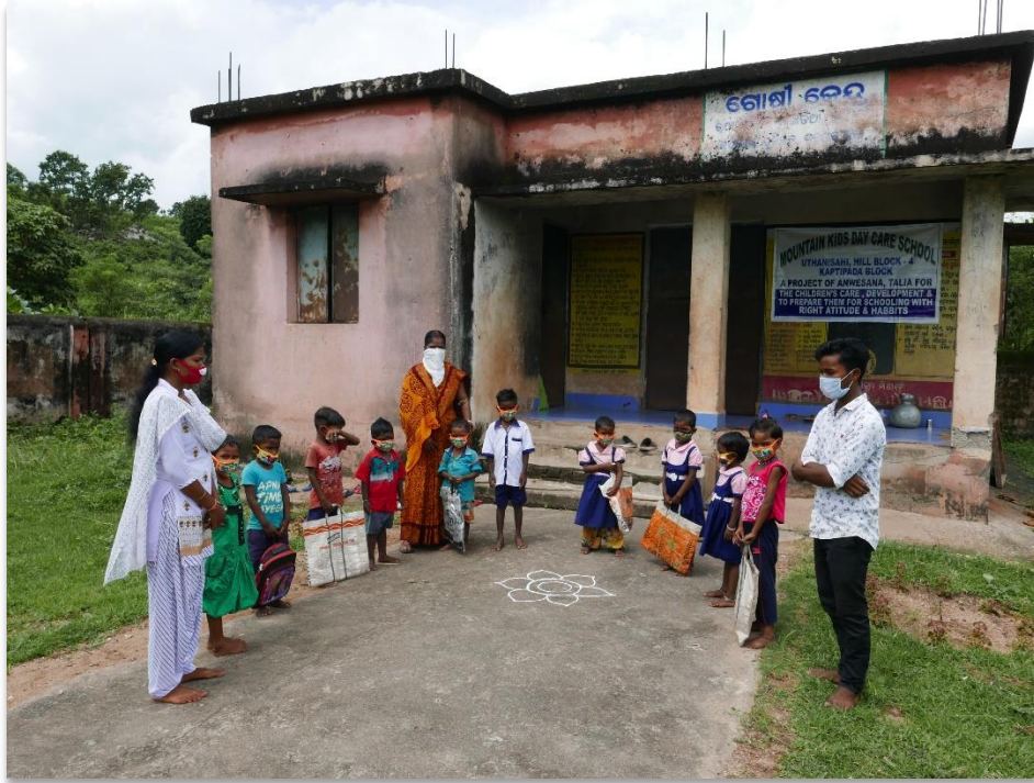
Altes Gemeindehaus. Umnutzung als Tagesschule für Anwesana
